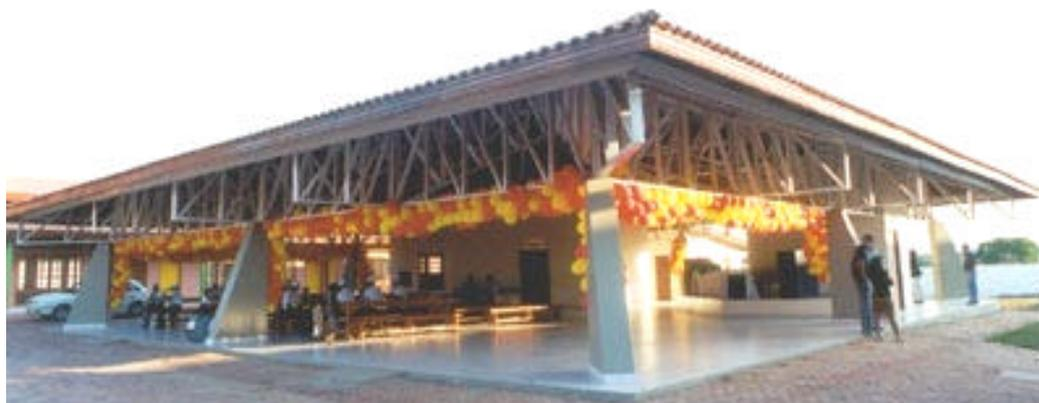
**Figura 3.19 – Refeitório coberto com pilares em concreto e vigas de cobertura metálicas treliçadas. Fonte: ACRE (2001)**
