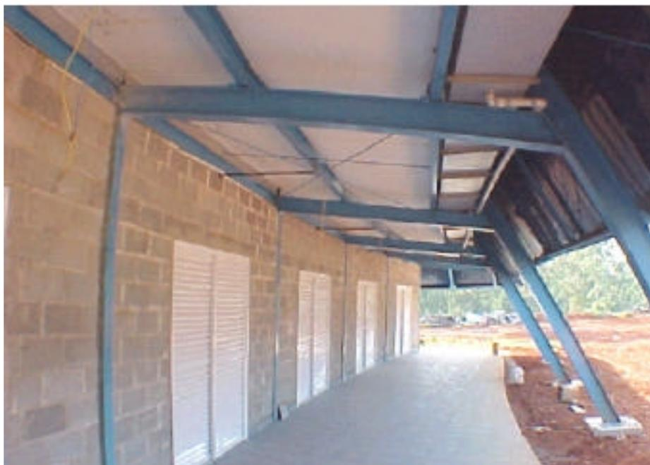
**Figura 5.11 – Assentamento de bloco de concreto x estrutura metálica. Fonte: BATTAGLIA (2002)**
