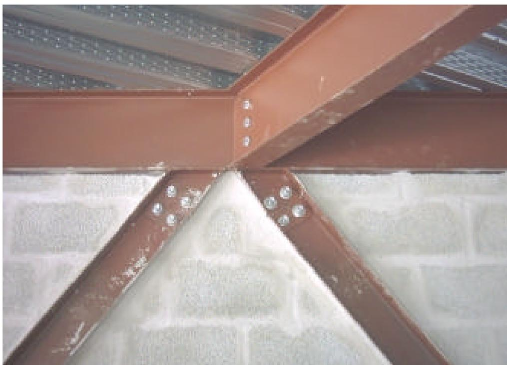
**Figura 5.12– Assentamento de bloco de concreto celular autoclavado x estrutura metálica.
