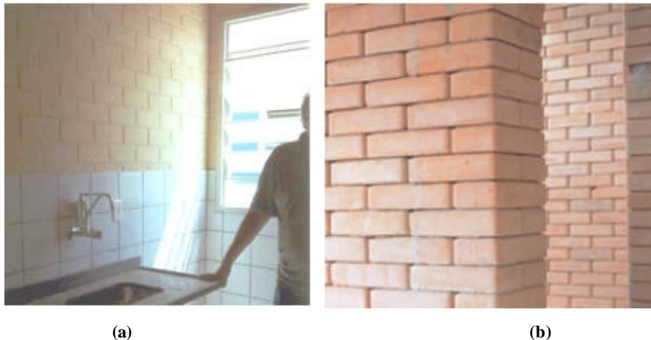
**Figura 5.14 – (a) e (b) Tijolo solo-cimento assentado sem argamassa e revestimento.**
