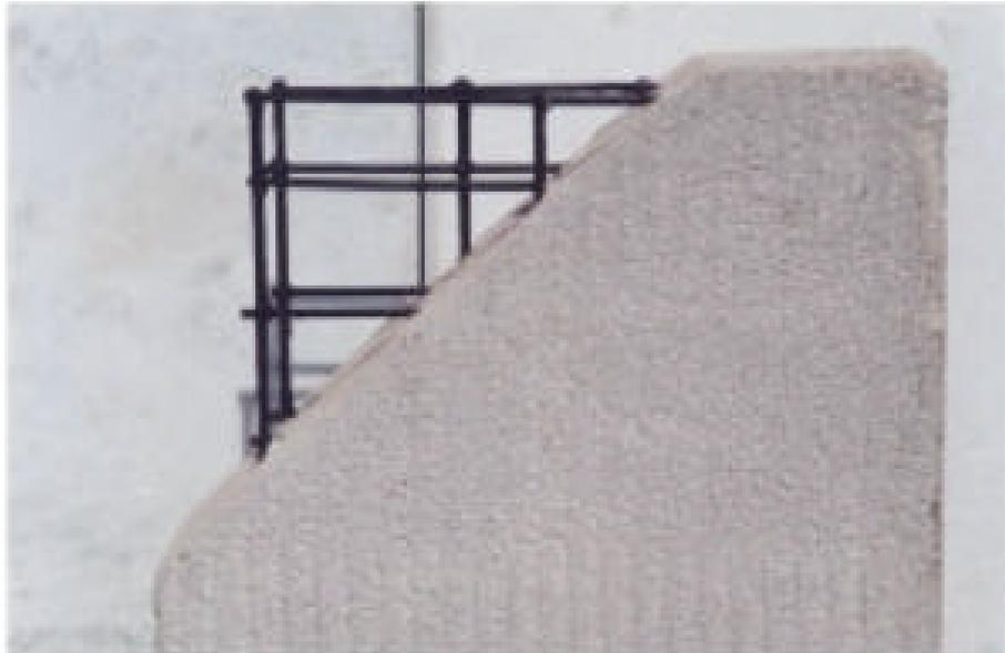
Figura 5.20 – Detalhe da armação interna do painel sical. Fonte: SICAL (2005)
