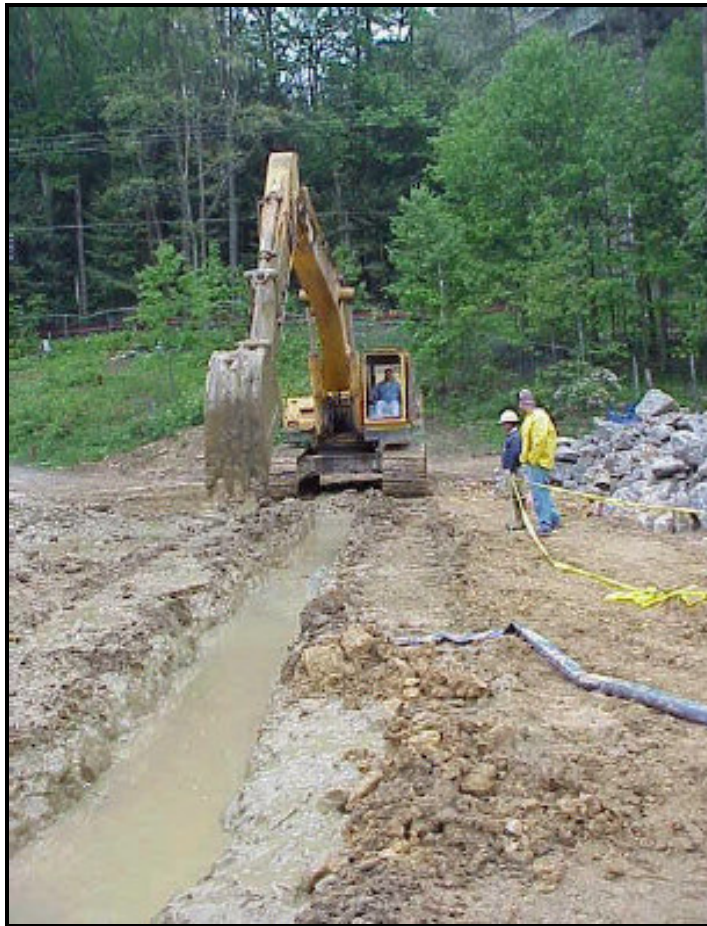
Figura 2.1: Escavação de uma trincheira (Ryan & Day, 2000).
