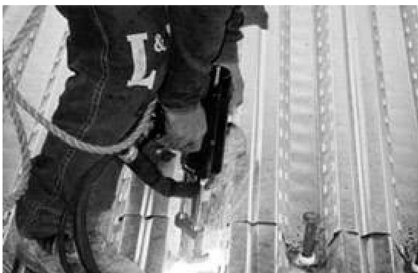
Figura 2.7 Colocação de stud bolts (www.metalica.com.br)
