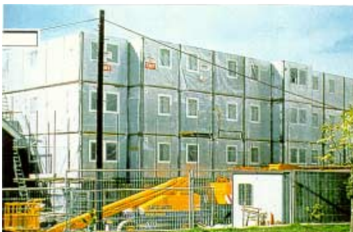
Figura 2.21 – Construção com Painéis Pré-Fabricados de Chapas de Aço.
