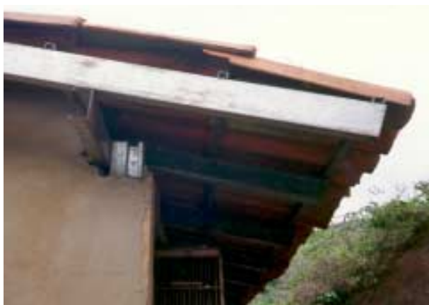
Figura 2.17B – Casa Popular em Ouro Preto. Detalhe da Coluna de Canto e da Estrutura do Telhado.
