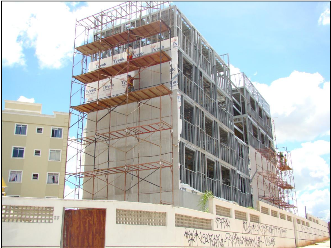
Vista da instalação da vedação externa
