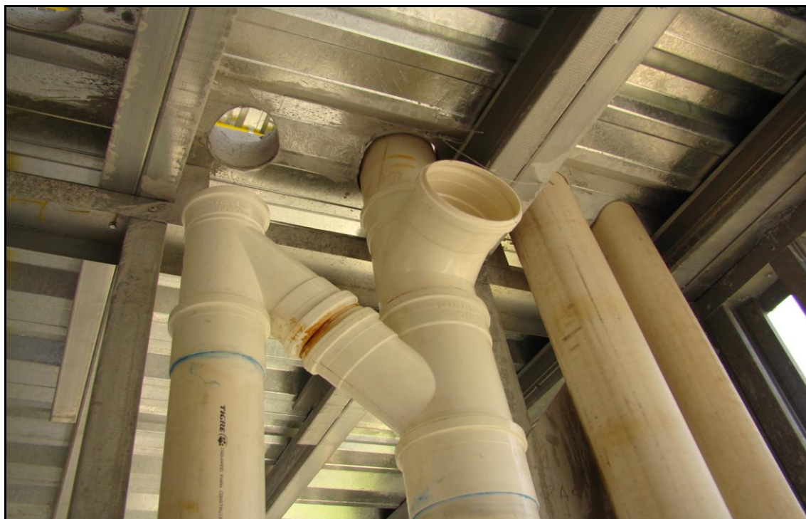
Detalhe da instalação hidráulica - furos na laje
