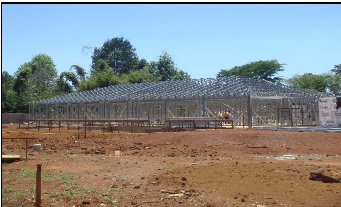
Figura 51: Montagem de residência com estrutura em aço
