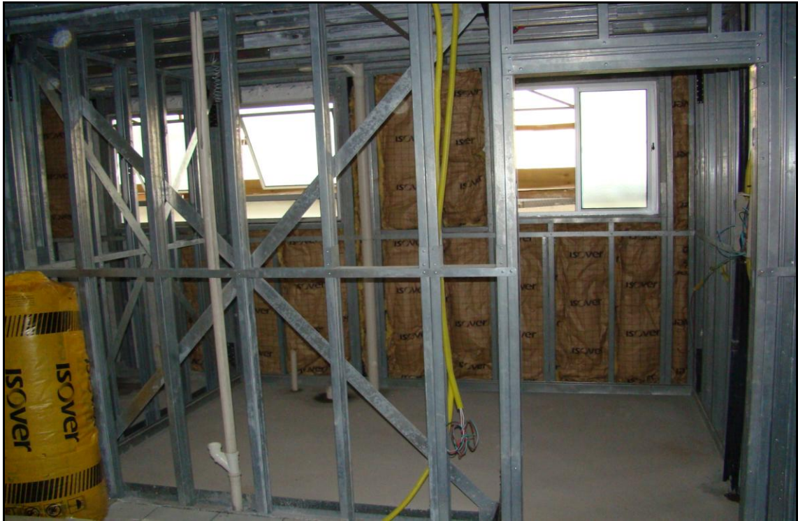
Vista da aplicação de isolante termo-acústico
