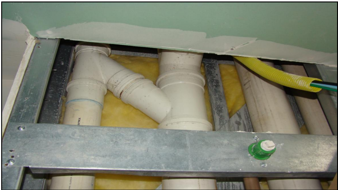
Vista interna de banheiro revestido por gesso acartonado hidrofugante
