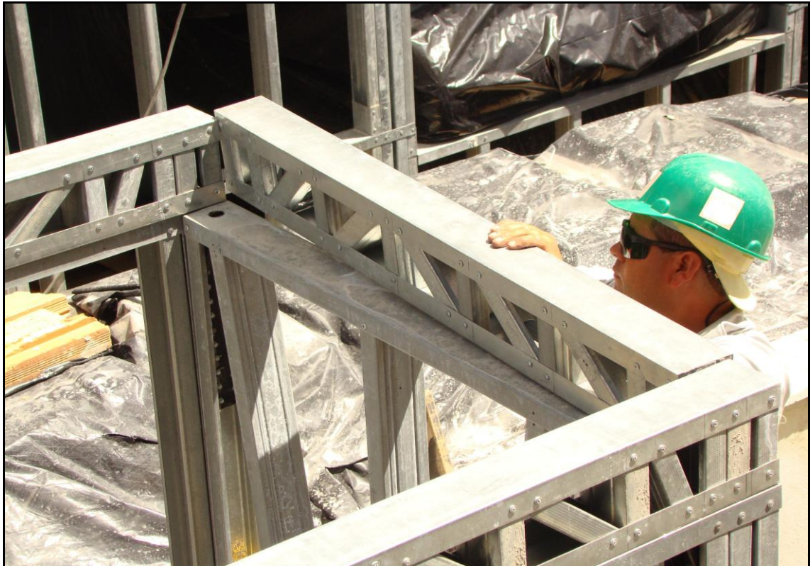
Montagem da estrutura da escada
