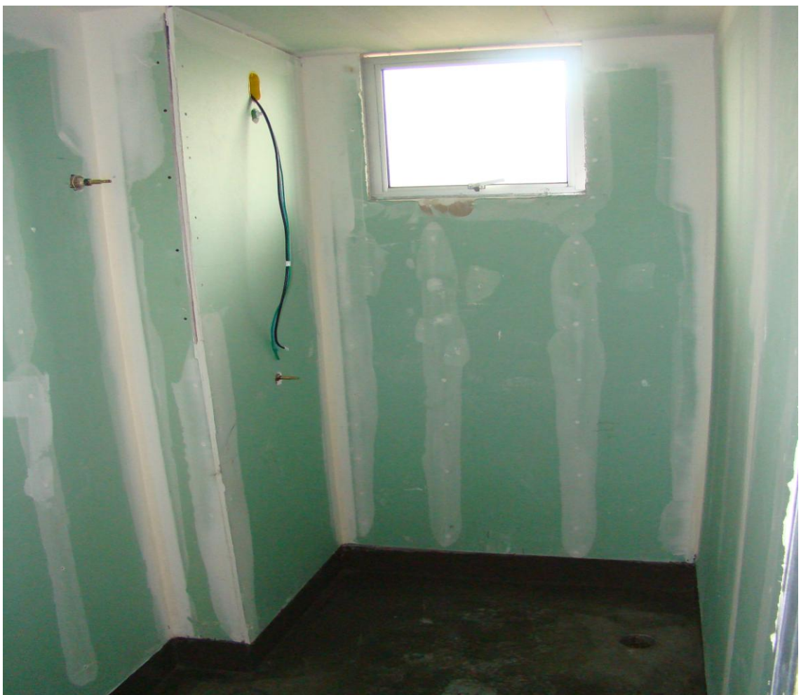
Vista interna de banheiro revestido por gesso acartonado hidrofugante
