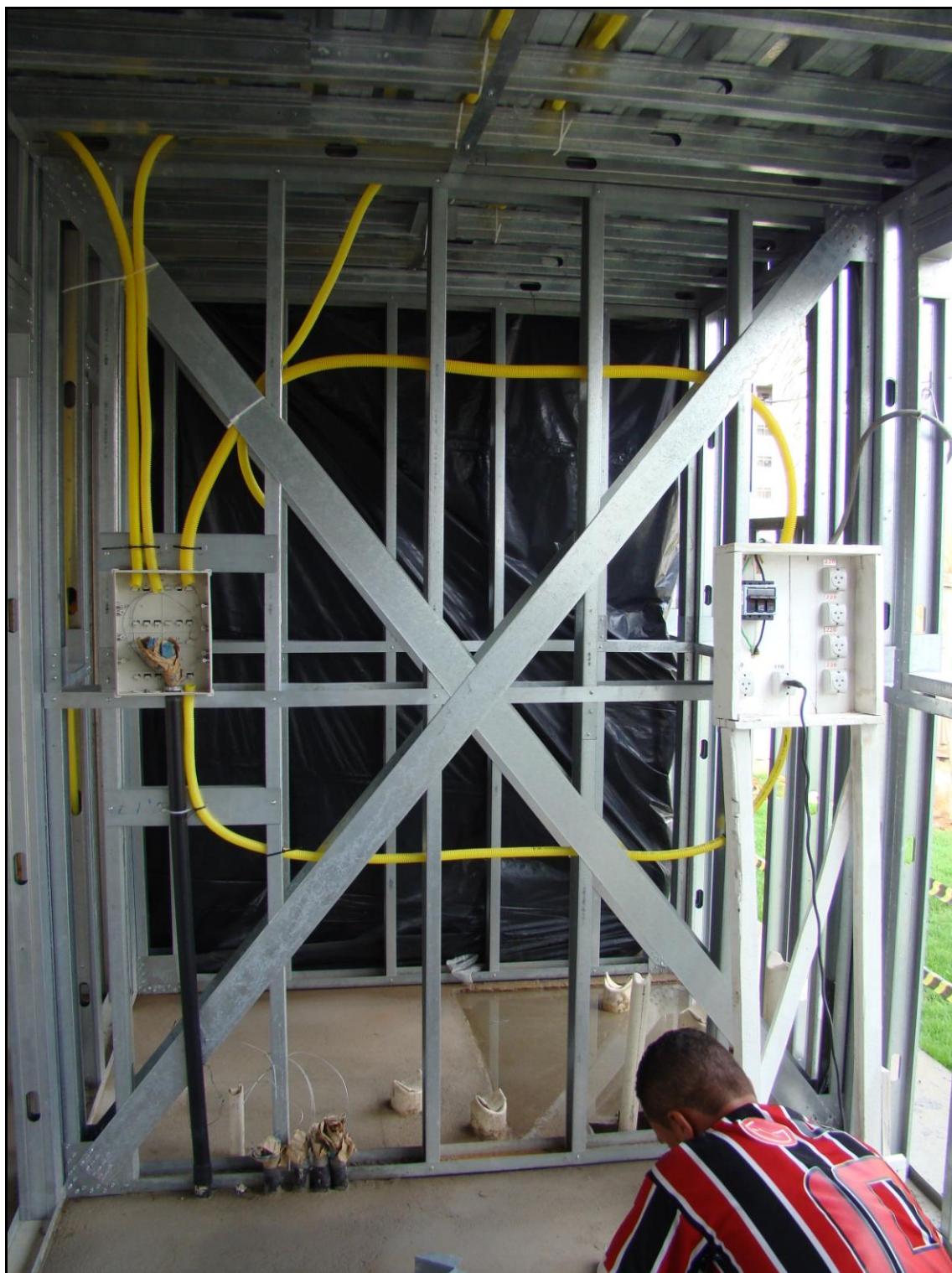
Vista das fitas metálicas – contraventamento
