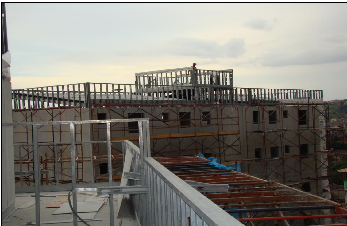
Vista da estrutura da cobertura, platibanda, barrilete e caixa d'água
