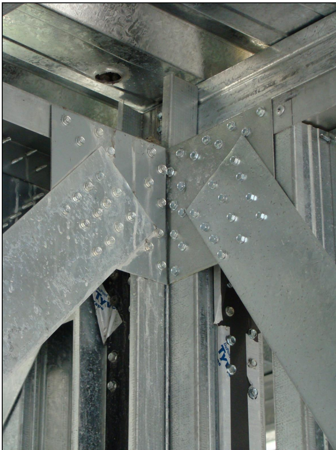
Detalhe da amarração do contraventamento
