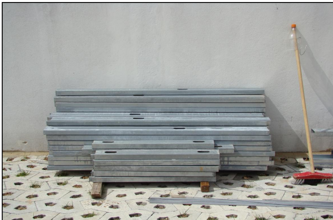
Estocagem de perfis metálicos
