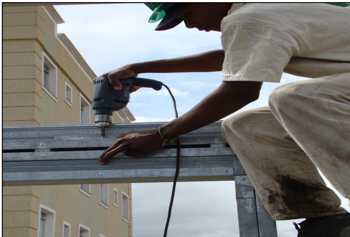
Parafusamento da estrutura
