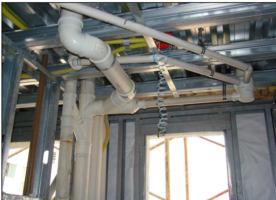
Vista das instalações - hidráulica e elétrica
