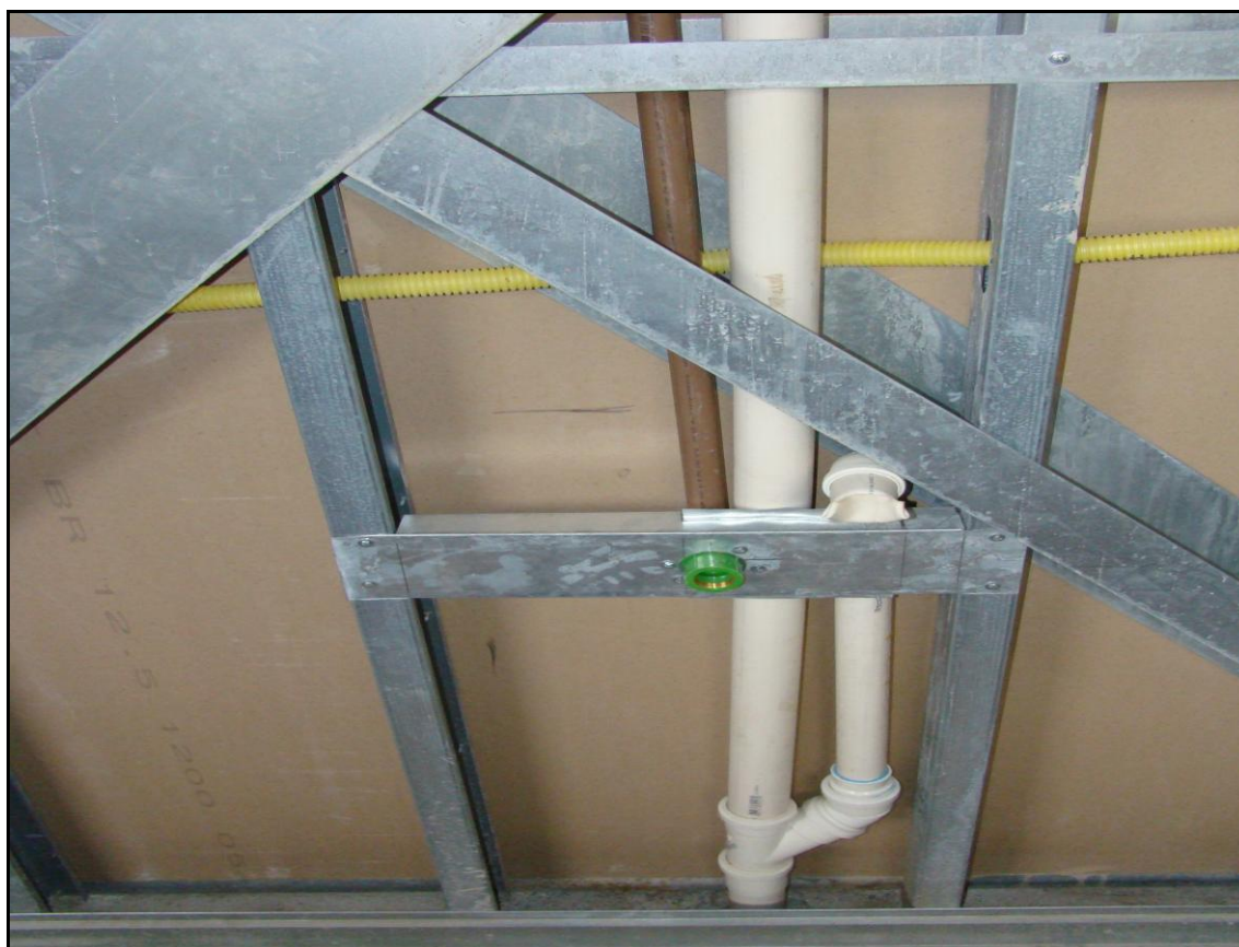
Detalhe de fixação na estrutura – hidráulica
