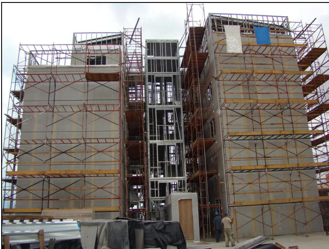
Vista da estrutura da caixa da escada
