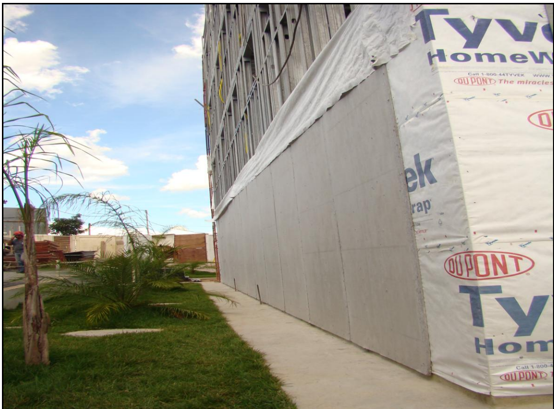
Aplicação de placa cimentícia – vedação
