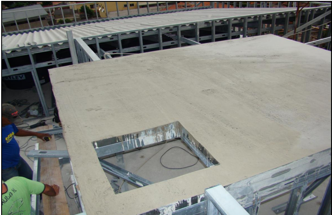
Vista de laje em concreto com forma metálica incorporada - cobertura
