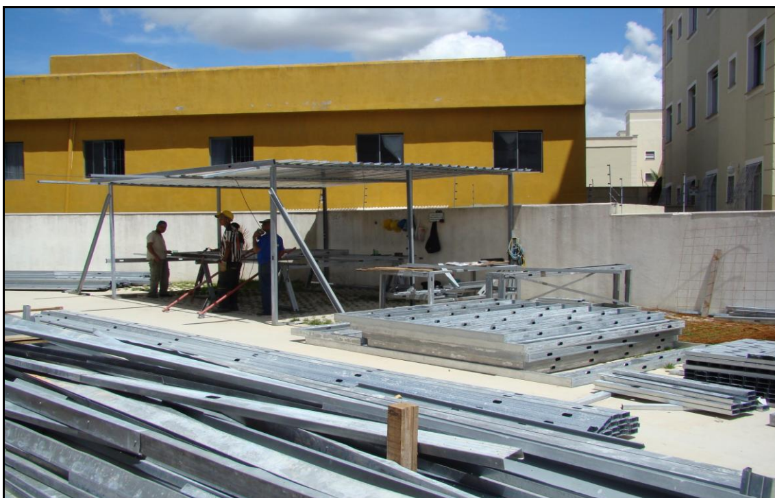
Montagem dos painéis metálicos
