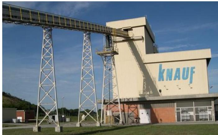
Figura 6.4- Correia transportadora que leva a gipsita para a fábrica.
