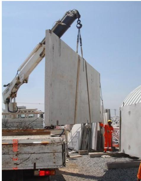
Figura 7.15: Retirada do painel do estoque.
