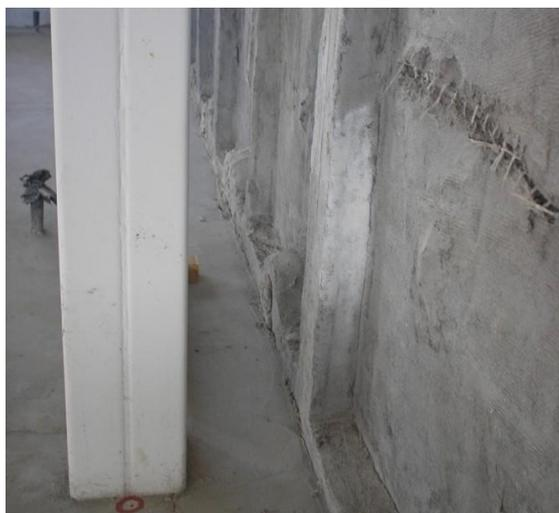
Figura 7.14: Pannel externo GFRC instalado. Detalhe para as fibras de vidro.
