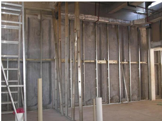
Figura 7.13: Pannel externo com acabamento de sistema Drywall no interior pronto para receber o fechamento em pannel acartonado.
