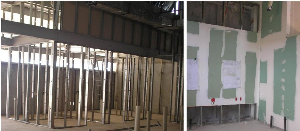
Figura 7.10: Fechamento interno CENPES II. (a) Estrutura em *Drywall* pronta para receber os painéis de fechamento. (b) Aplicação de painéis de gesso acartonado. Visita CENPES II, 6 out. 2009.
