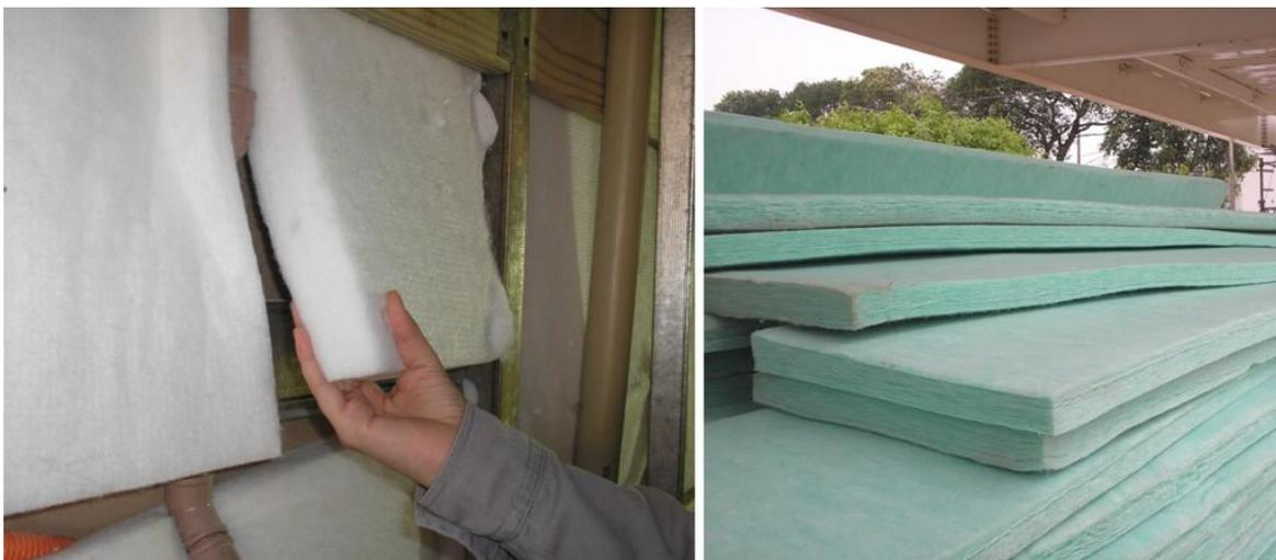
Figuras 7.11: Fechamento interno CENPES II. (a) Material isolante térmico fabricado a partir de garrafa pet transparente aplicado entre a estrutura em *Drywall*. (b) Material isolante térmico fabricado com garrafa pet verde estocado.
