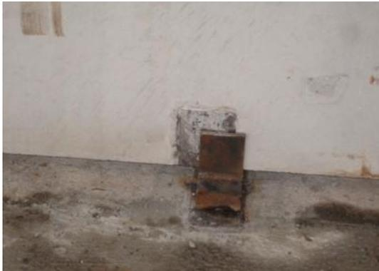
Figura 7.23: Chapa de fixação no local não bate com o painel.
