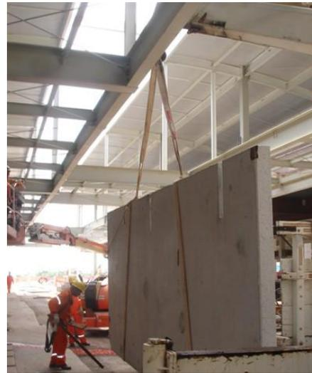
Figura 7.24: Espaço não adequado para içamento.
