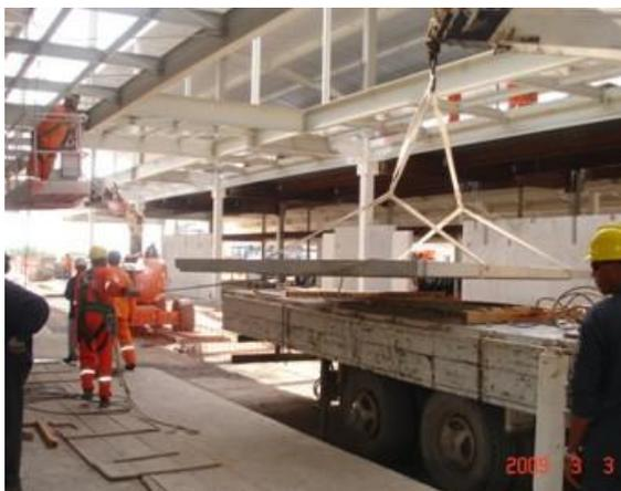
Figura 7.19: Retirada do painel.
