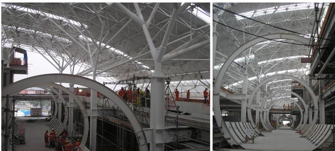
Figura 7.8: Prédio central do CENPES II em construção. (a) Detalhe da cobertura. (b) Detalhe do túnel.
