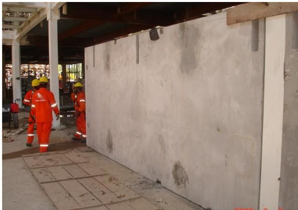
Figura 7.22: Posicionamento do painel.
