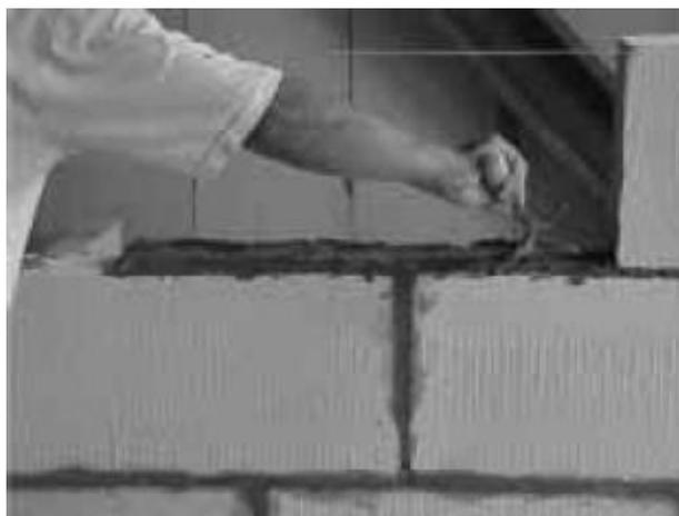
Figura 5.2- Assentamento de blocos para alvenaria:
