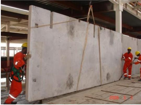
Figura 7.20: Posicionamento do painel.
