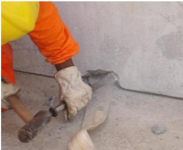
Figura 7.25: Dificuldade na retirada da cinta.
