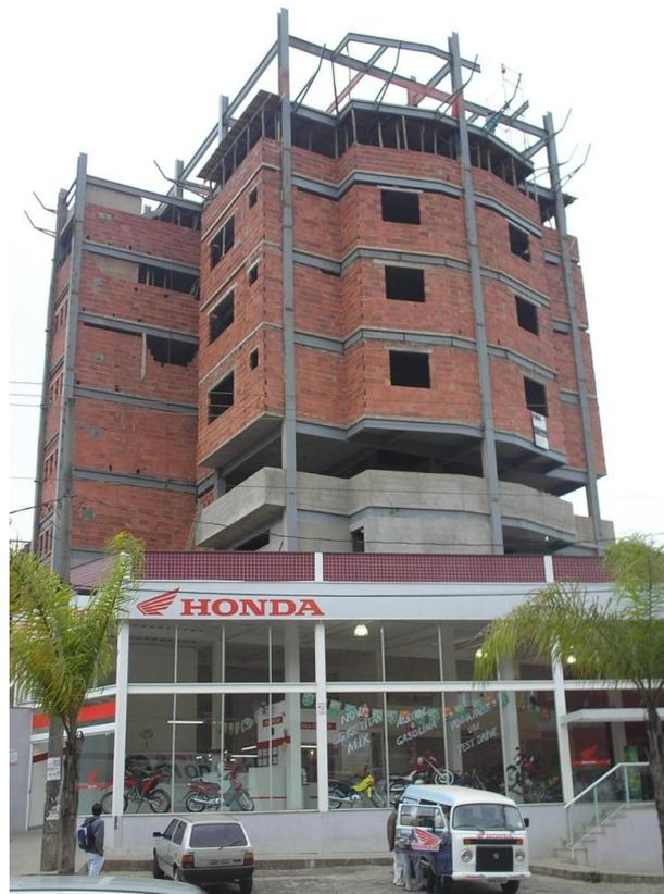
Figura 5.1- Edificação estruturada em aço com fechamento em alvenaria tradicional em Viçosa/MG, dez. 2009.
