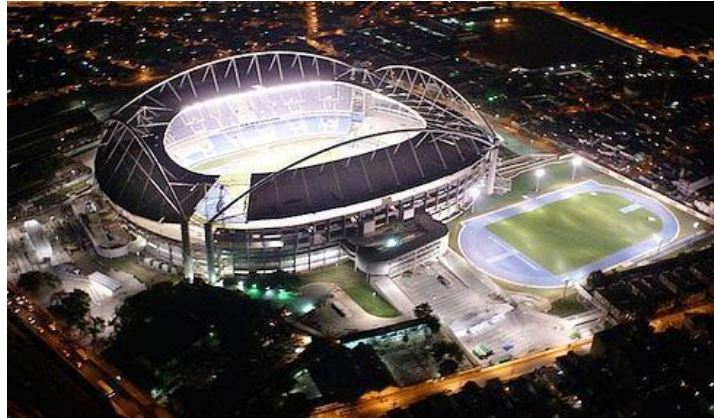
Figura 1.3 - Treliça espacial - Estádio João Havelange "Engenhão", Rio de Janeiro/Brasil. Fonte: Disponível em < http://diariodorio.com/fotos-do-engenhao-a-noite >. Acesso em: 20/04/2010.
