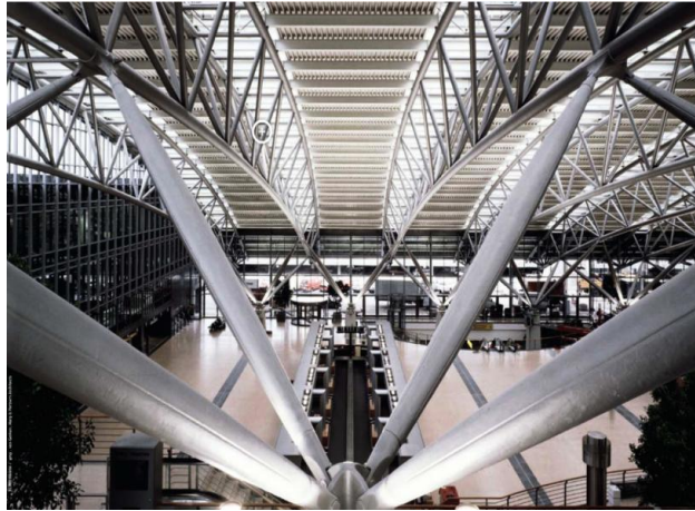
Figura 1.5 - Treliça espacial - Aeroporto de Hamburgo, Alemanha. Fonte: Mayor 2010.
