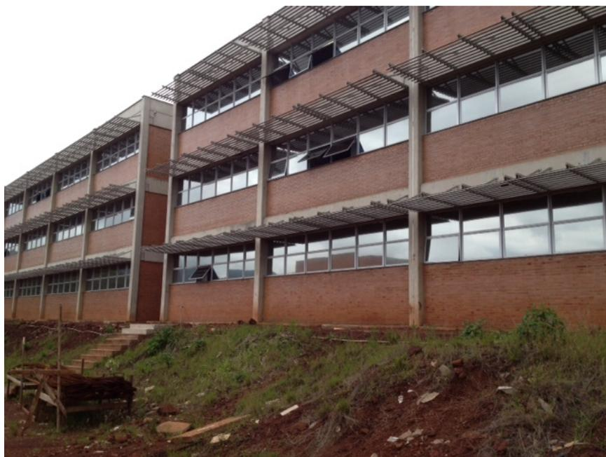
Figura 5.61- Brise soleil horizontal fachada oeste ICEB III.
