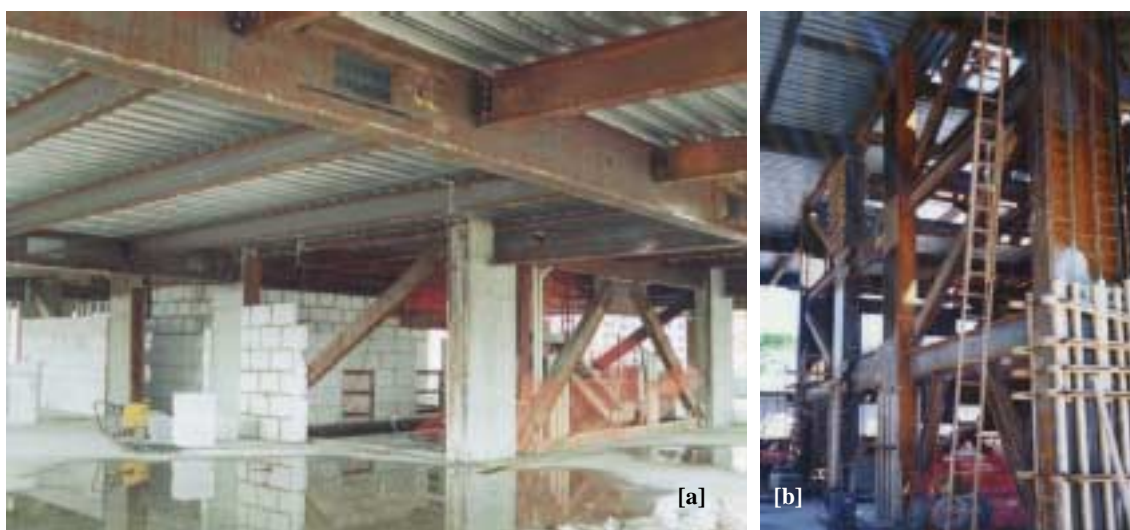
FIGURA 4.28 – Vista interna dos contraventamentos localizados junto ao núcleo de circulação vertical: (a) a partir do pavimento-tipo; (b) a partir do pavimento térreo.
