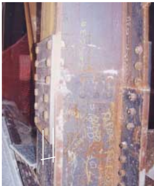
FIGURA 4.49 – Vista, em detalhe, da ligação entre colunas, com chapa vertical.
