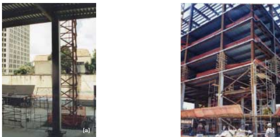
FIGURA 4.29 – Ilustração da solução de contraventamento adotada: (a) vista interna, mostrando a altura da coluna (600x600mm) sem travamento lateral; (b) vista externa, dos contraventamentos.
