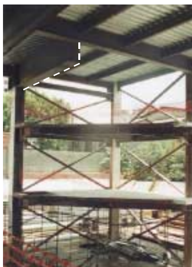
FIGURA 4.27 – Vista interna das vigas de suporte do primeiro andar-tipo, mostrando uma das vigas dimensionadas para absorver os esforços devido às transições estruturais.
