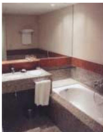
FIGURA 4.10 – Vista interna do módulo de banheiro instalado. Fonte: DIAS (2001)
