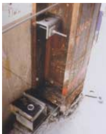
FIGURA 4.65 – Vista, em detalhe, da solução dada para a fixação dos painéis de fachada industrializados na estrutura.
