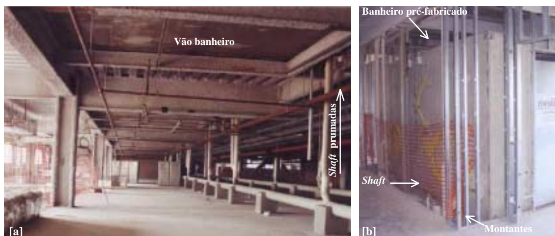
FIGURA 4.4 – Visualização das soluções propostas para os sistemas de instalações e ar-condicionado, durante a etapa de execução: (a) vista do andar técnico e (b) vista do shaft a partir da circulação do andar de apartamentos.
