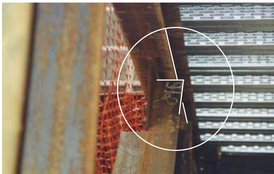
FIGURA 4.48 – Vista, em detalhe, da dimensão das mesas do contraventamento em relação à viga.
