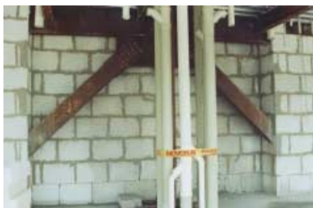
FIGURA 4.30 – Vista interna a partir do pavimento-tipo, mostrando parte do contraventamento enclausurado na alvenaria, antes da aplicação do revestimento.
