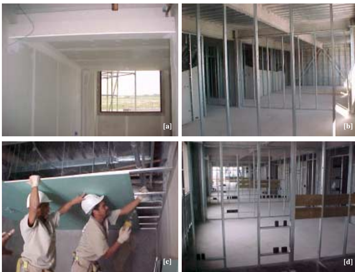
FIGURA 4.7 - Vista interna do apartamento, mostrando as placas de gesso acartonado utilizadas como: (a, b e d) vedação; (a) acabamento; (c) forro. Fonte: Construtora C-1.
