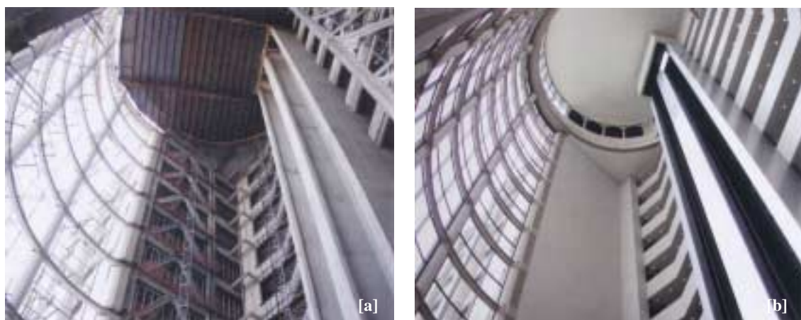
FIGURA 4.15 – Vistas da cobertura do átrio: (a) do piso provisório utilizado durante a execução; (b) após a execução; Fonte: DIAS (200).
