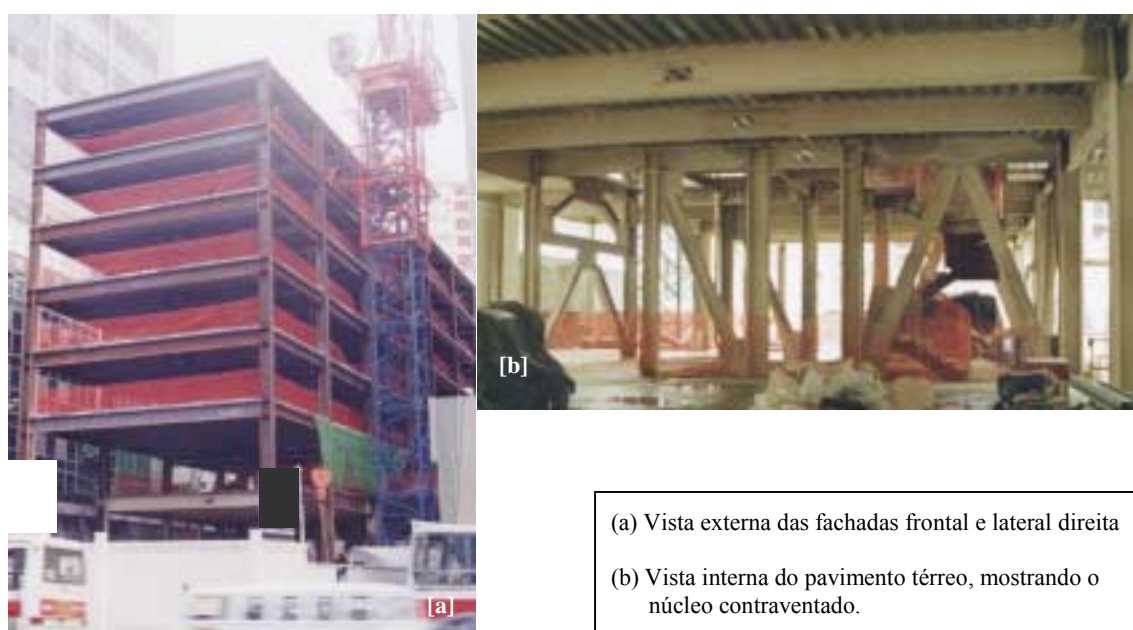
FIGURA 4.42 – Vistas externa e interna do edifício, durante a montagem da estrutura.
