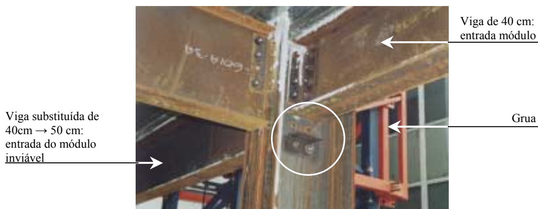
FIGURA 4.47 – Vista em detalhe da viga substituída durante a montagem.
