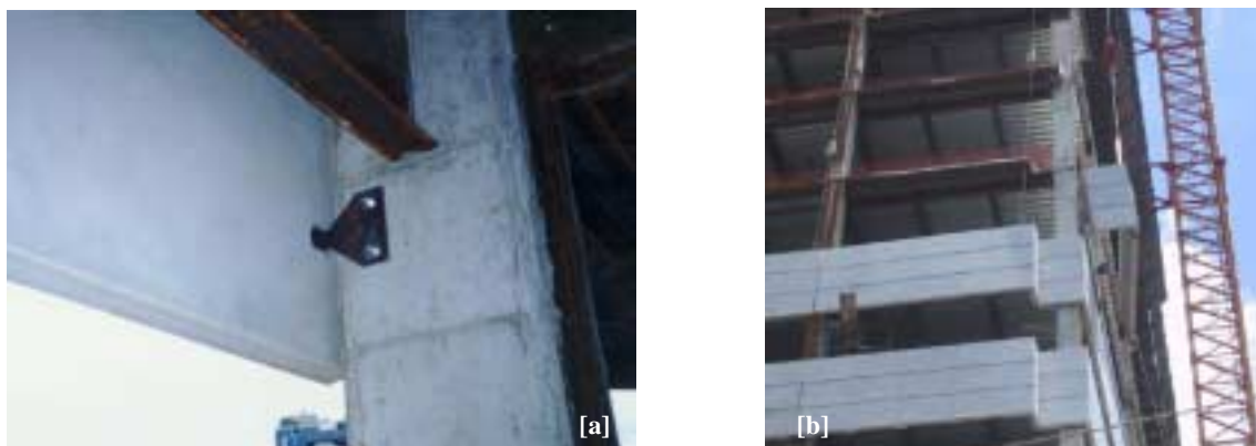
FIGURA 4.38 – Vistas do painel de fachada industrializado: (a) vista interna, com detalhe da fixação do painel de concreto no pilar; (b) vista externa, mostrando a montagem do painel.
