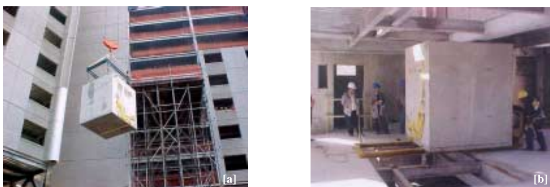
FIGURA 4.9 – Vistas da instalação do módulo de banheiro: (a) içamento; (b) posicionamento. Fontes: (a) Construtora; (b) DIAS (2001).
