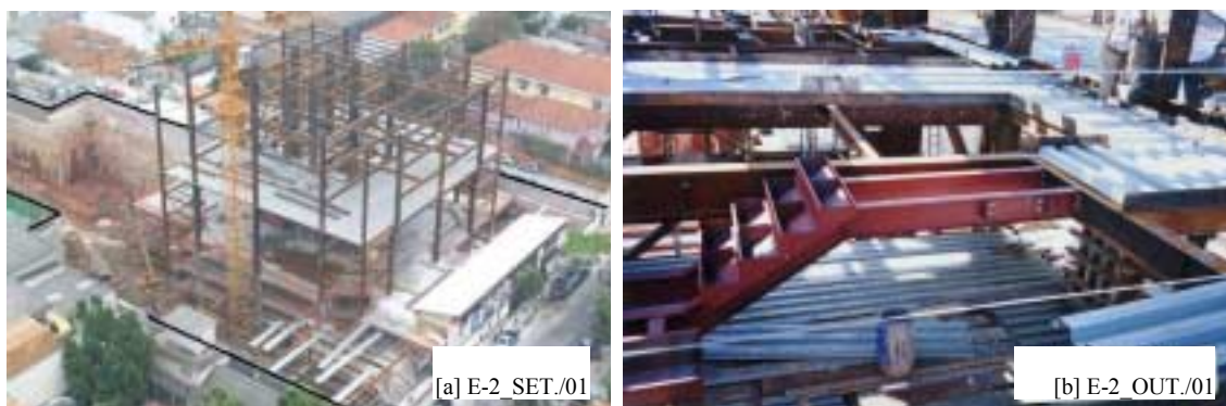
FIGURA 4.22 – Ilustrações do sistema estrutural do E-2, durante a montagem: (a) vista panorâmica; (b) vista interna, a partir de um dos andares-tipo.
