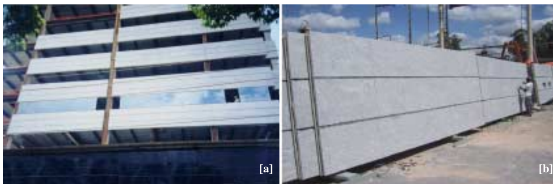
FIGURA 4.23 – Sistema de fechamento vertical de fachada: (a) vista externa mostrando esquadrias e painéis de concreto instalados, durante a execução do E-2; (b) vista do painel de concreto, na fábrica.
