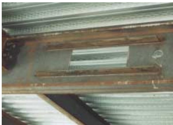
FIGURA 4.37 – Detalhe da solução adotada para reforço dos furos nas vigas.
