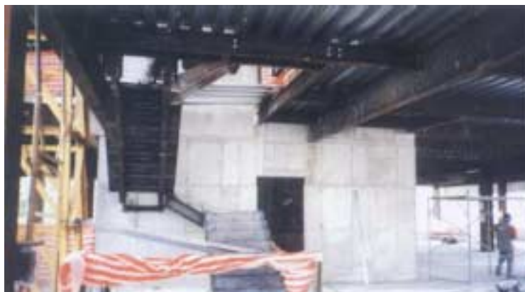
FIGURA 4.59 – Vista interna do núcleo rígido de concreto no nível do subsolo. Fonte: DIAS (2001).
