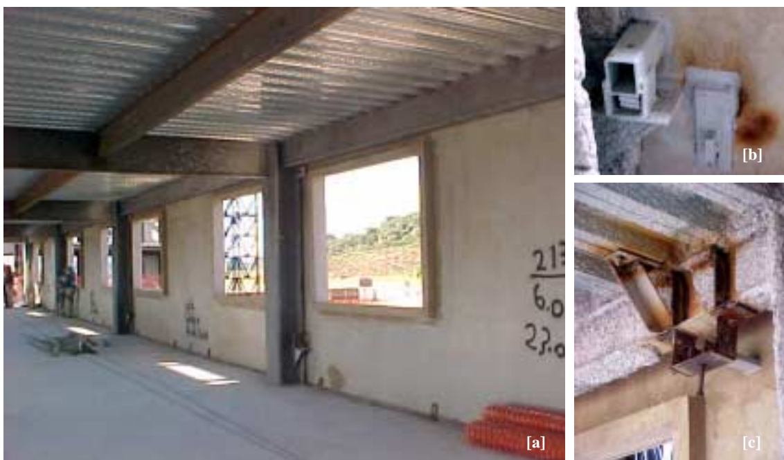
FIGURA 4.6 - Vistas internas, mostrando (a) os painéis pré-fabricados de concreto maciço, (b) um detalhe de fixação do painel em coluna e (c) um detalhe de fixação do painel em viga. Fonte: Construtora C-1.
