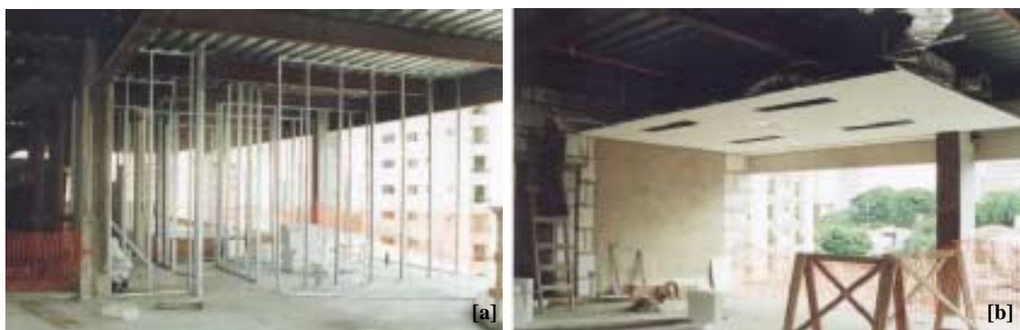
FIGURA 4.24 – Vistas internas de um andar-tipo: (a) montantes para fixação das placas de gesso acartonado; (b) forro de fibra mineral e blocos de concreto celular autoclavado.
