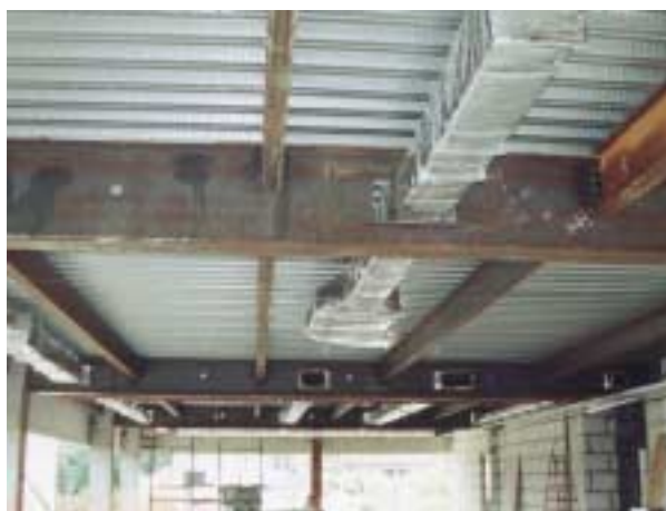
FIGURA 4.34 – Solução apresentada para o sistema de serviço do edifício E-2: vista do entreferro do conjunto 02, durante a fase de execução.
