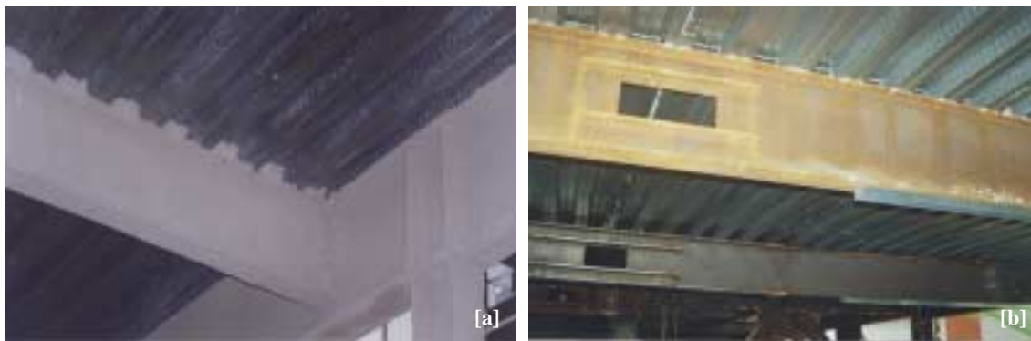
FIGURA 4.43 – Vistas internas da estrutura: (a) elementos do térreo com proteção passiva; (b) vigas do tipo furadas e com as guias fixadas.
