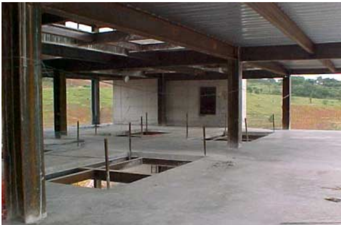
FIGURA 4.5 – Vista interna do andar-tipo, mostrando o sistema estrutural adotado. Fonte: Construtora C-1.
