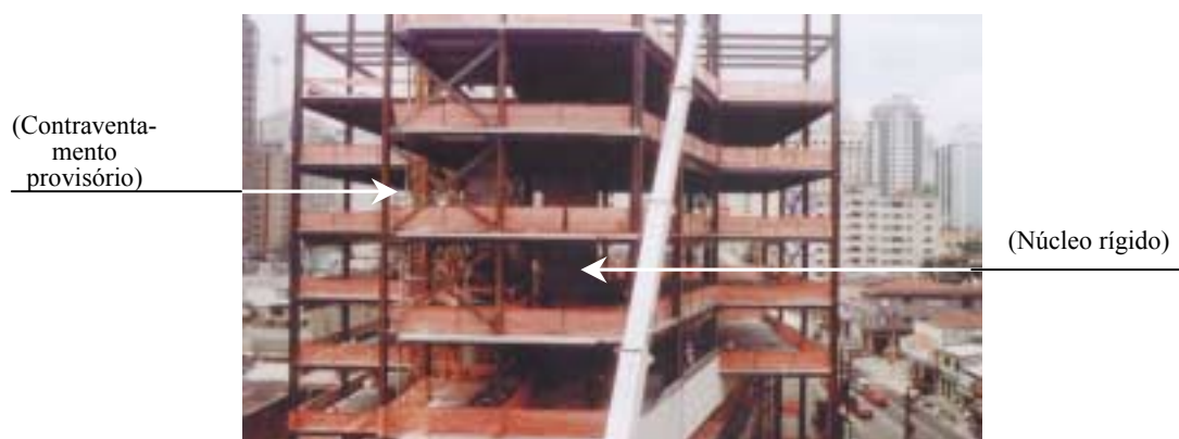
FIGURA 4.54 – Vista externa do esqueleto estrutural, durante a etapa de execução.
