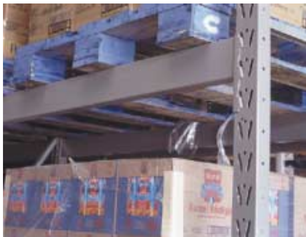
Figura 2.1 – Detalhe da ligação de encaixe entre a viga e a coluna (Altamira (2002)).
