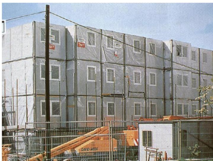
Figuras 4.10 – Módulos estruturais instalados (IISI, 1996, pg 35)
