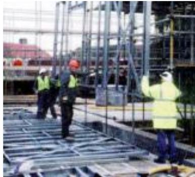
Figura 4.6 – Seqüência de montagem de frames de parede (SCI, 1994, p. 26)
