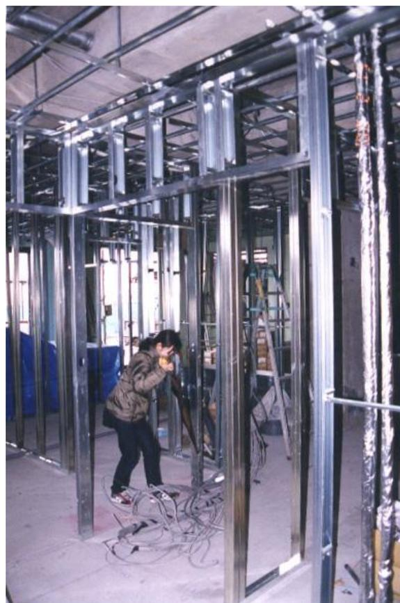
Figura 4.27– Imagem dos componentes estruturais do sistema no Japão. (fotografia arquivo pessoal do autor, 2000)
