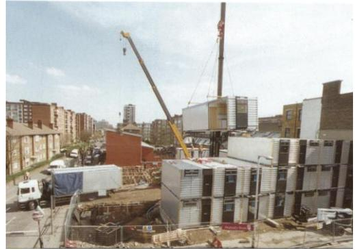
Figura 5.4: Montagem do edifício (THE ARCHITECTS' JORUNAL, 1999, p. 27)
