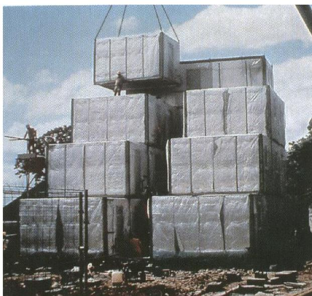
Figuras 4.9 – Sistema de montagem de módulos estruturais (IISI, 1996, pg 35)
