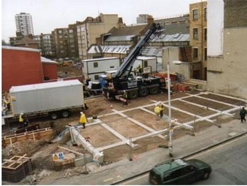
Figura 5.3: Início da montagem do edifício (THE ARCHITECTS' JORUNAL, 1999, p. 27)
