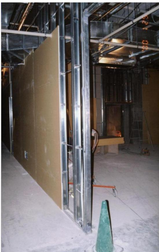
Figura 4.26– Imagem dos componentes do sistema com a placa de gesso acartonado no Japão. (fotografia arquivo pessoal do autor, 2000)
