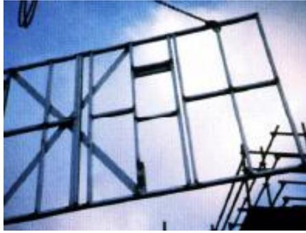
Figura 4.5 – Transporte da grade estrutural (SCI, 1994, p. 26)
