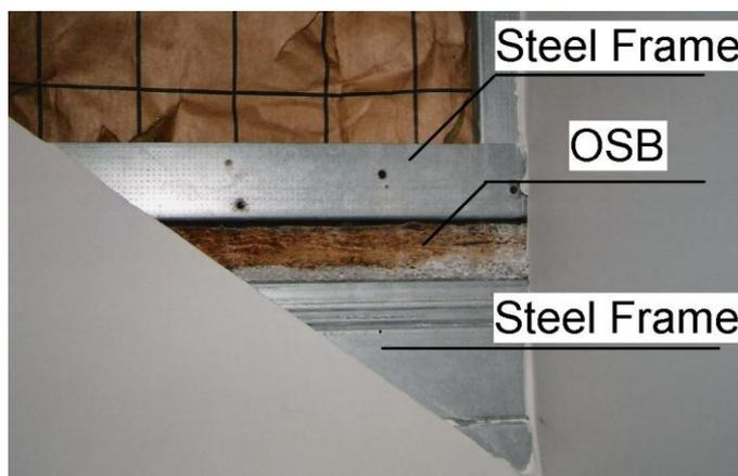
Figura 4.32 – Foto do painel OSB instalado (fotografia arquivo pessoal do autor)
