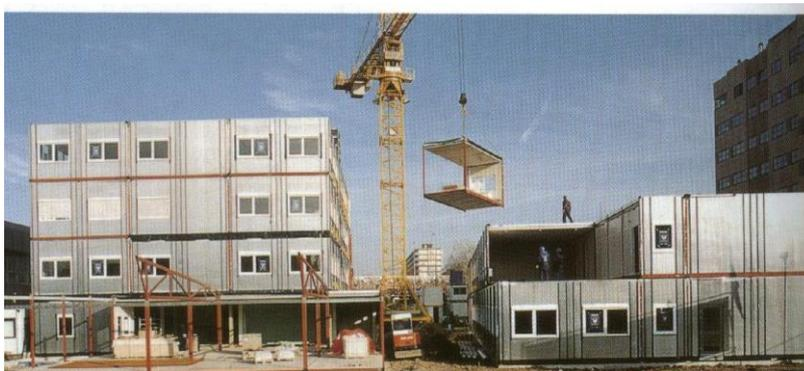
Figura 5.19 : Sistema de montagem de uma edificação em sistema modular (IISI, 2000, p. 04)
