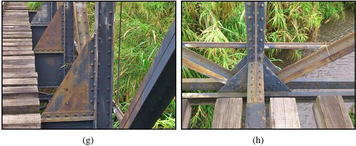
**Figura 4.5** – Registro fotográfico da “Ponte da Estação de Ouro Preto/MG” (2014); (a) vista frontal; (b) vista lateral; (c) detalhe do pilar; (d) contraventamento na parte inferior da estrutura; (e) patologias no aparelho de apoio fixo; (f) patologias no aparelho de apoio móvel; (g) detalhe da ligação em chapa; (h) detalhe da ligação entre diagonais e montantes.
