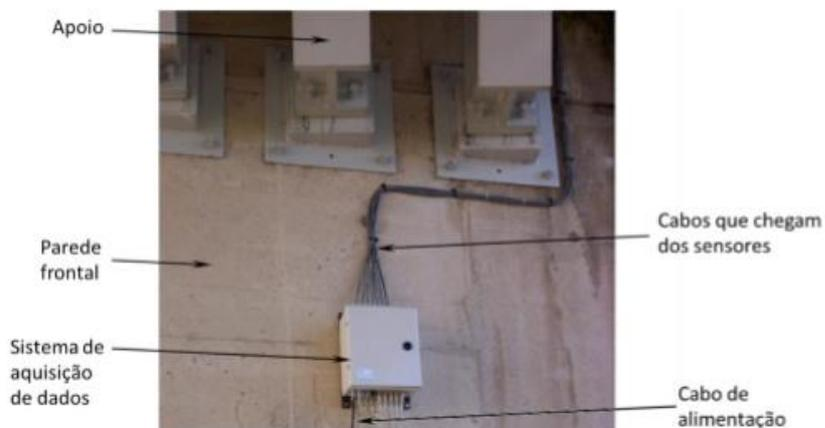
FIGURA 74 - Vista do sistema de aquisição de dados e dos cabos. FONTE – CURY, 2010.
