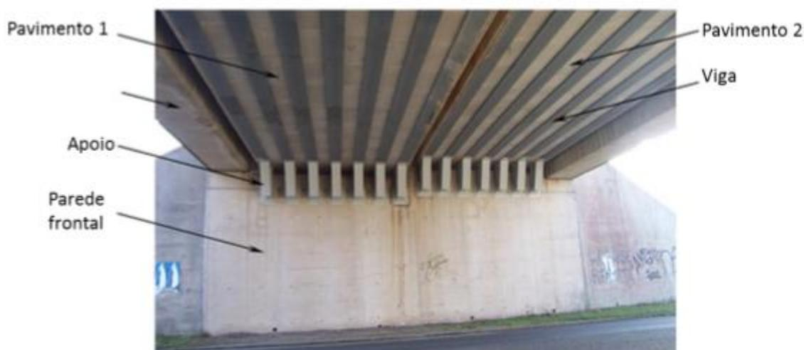
FIGURA 76 - Representação do sistema de mancais. FONTE – CURY, 2010.
