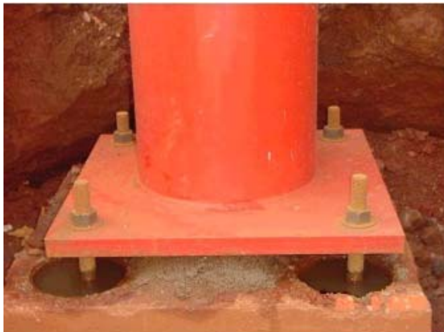
Figura A.3 – Detalhe de fixação da placa de base, durante a colocação do grout . Fonte: Vallourec & Mannesmann Tubes
