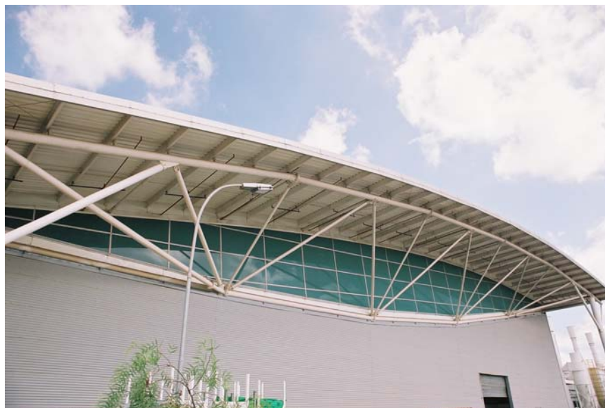
Figura 6.10- Pannel metálico perfilado, Fábrica Valeo, SP.
