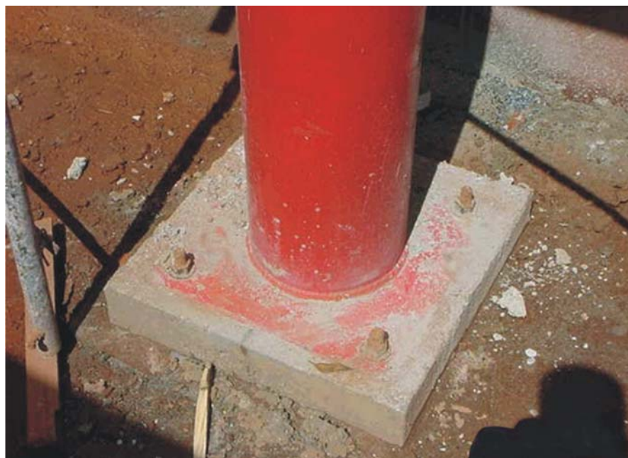
Figura A.4 – Detalhe do assentamento da coluna após a colocação e endurecimento do grout . Fonte: Vallourec & Mannesmann Tubes
