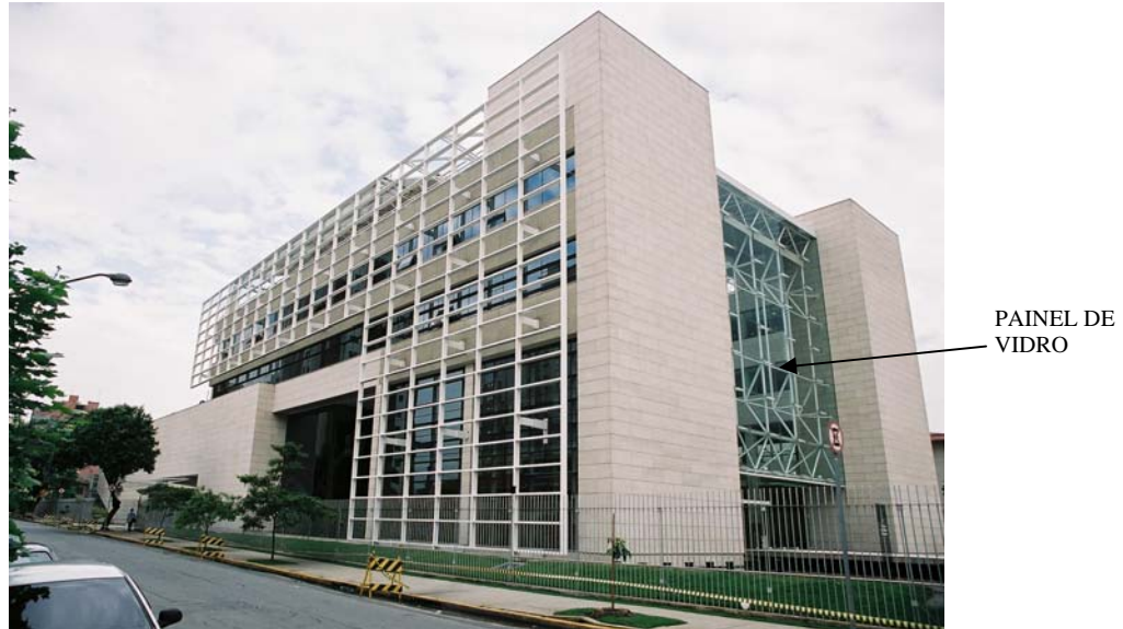
Figura 7.18- Pannel de vidro suspenso. Centro Britânico Brasileiro, SP. Fonte: BITTAR (2004, f)
