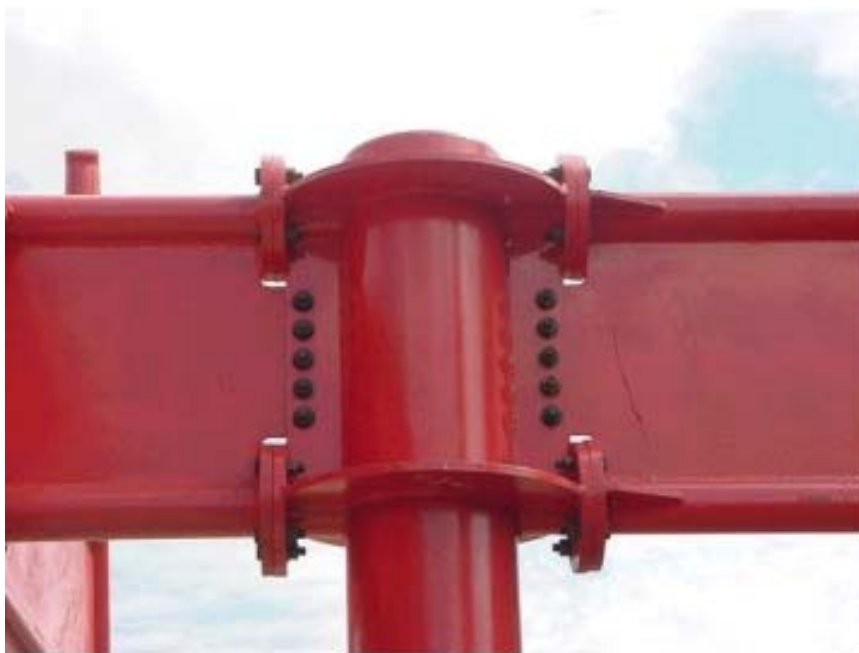
Figura A.13- Detalhe da ligação rígida entre vigas compostas e pilar tubular com seção circular.
