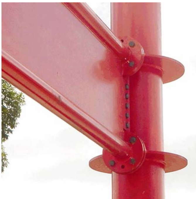
Figura A.14- Detalhe da ligação rígida entre viga composta terminal e pilar tubular circular.
