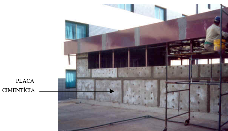
Figura 6.1- Fachada revestida com placa cimentícia.
